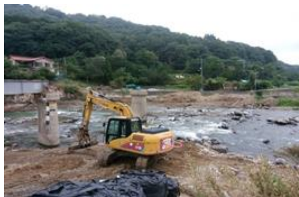
芸備線 第一三篠川橋梁
