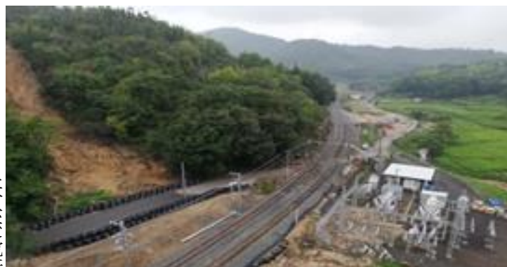
八本松変電所
